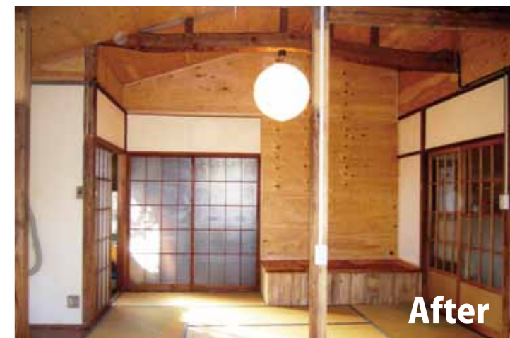
After. 沈下していた床と雨漏りをしてきた屋根の修繕。空間を隔てていた壁の撤去などこれまで抱えていた問題点をすべて解消！天井も取り払われて開放的な空間を創出。室内の特製ベンチや壁の漆喰の手塗りなど、随所に見どころ満載の集会所となりました。
